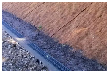
https://www.apstatyba.lt/naturalaus-pluosto-prieseroziniu-paklotu-analize-1545 pav. Sankasos šlaito tvirtinimas šiaudų dembliais
