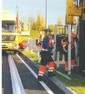
http://www.biseris.lt/projektai/gatves/ pav. Statramsčių kalimas į žemę
