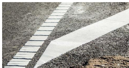
2 pav. Ženklinimas šaltu plastik
