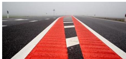
1 pav. Ženklinimas karštu plastik
