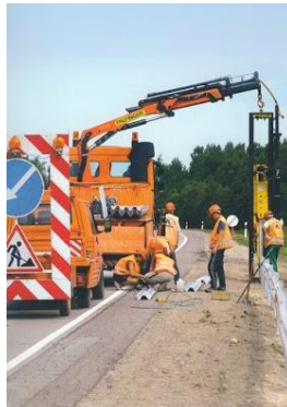
http://www.biseris.lt/projektai/gatves/ pav. Kelio aptvėrimas metalinėmis sijomis, tvirtinant jas ant metalinių statramsčių
